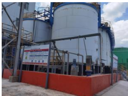
脱重工序围堰
